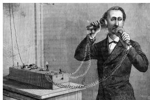
Le microphone (souvent appelé micro) est né en 1876 lorsque Alexander Graham Bell invente le téléphone. Il s'agit d'un appareil capable de convertir un signal acoustique en signal électrique. À l'inverse, le haut-parleur transformera un signal électrique en signal sonore.
